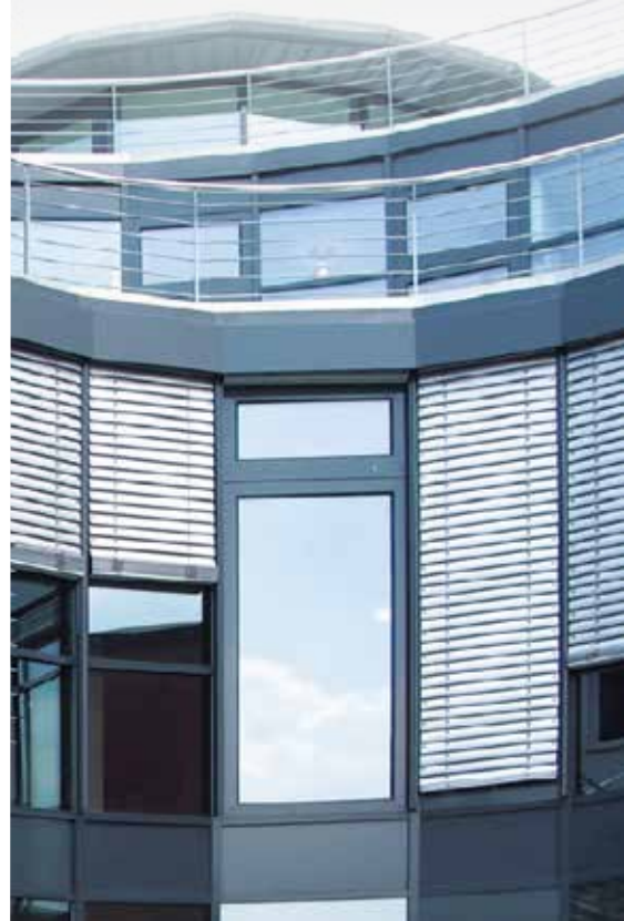
Witterungsbeständige, konkav-konvex gewölbte Aluminiumlamellen in 80er Breite mit Polygonalführungsschiene.
